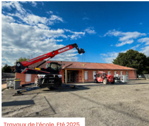
Travaux de l'école. Été 2025
