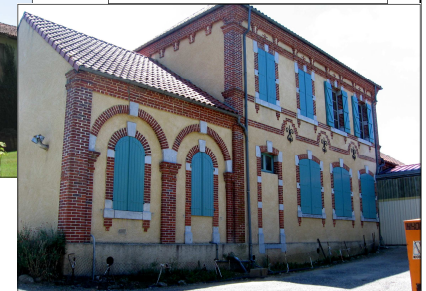
Encadrements en brique : ancienne école des filles
