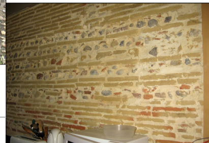
Mur de la cuisine de la maison de Berthe après piquetage du crépi . Maison lou Barbalai (chez M. Dupin)
