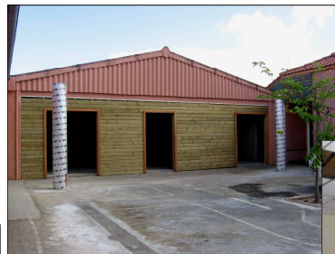
La rénovation en photos
